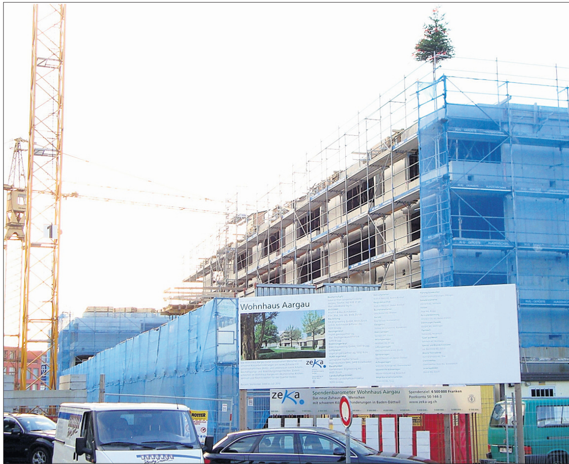
WOHNHAUS AARGAU Es geht zügig und planmässig voran mit den Bauarbeiten in Baden-Dättwil. PETRA BOLFFING
