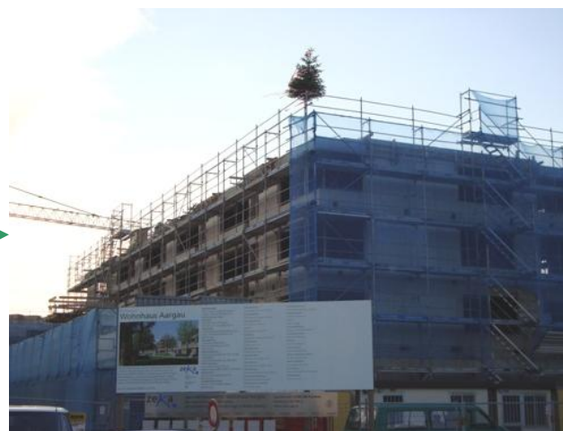
Bauplatz an der Hochstrasse (Juli 2009)
